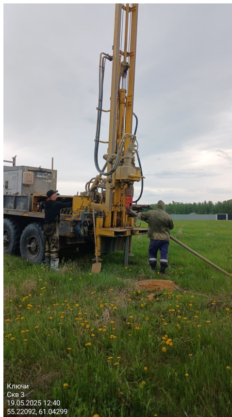
Бурение скважины №3
