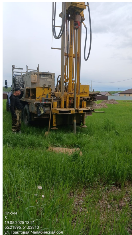
Бурение скважины №5
