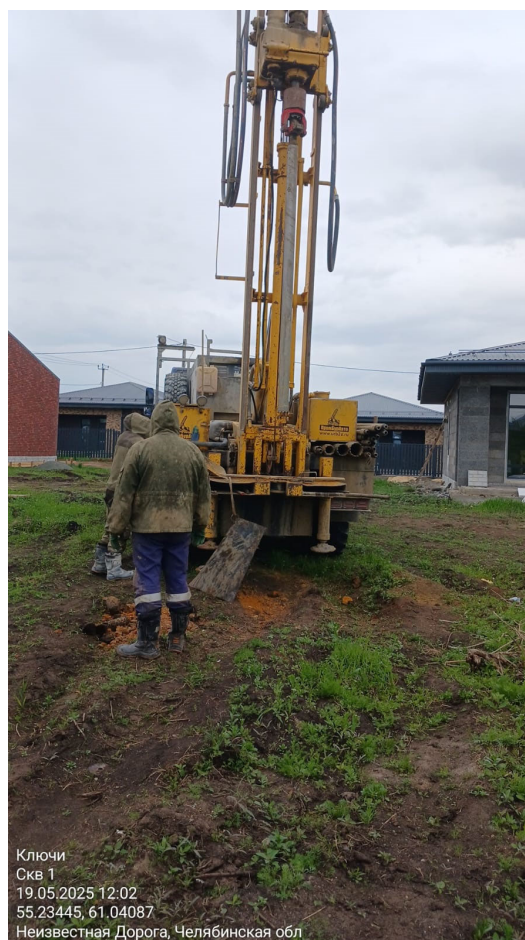
Бурение скважины №1
